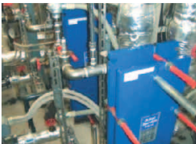
冷水熱交換器
