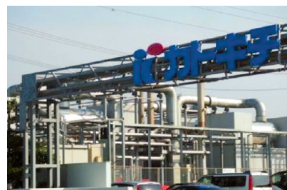
コージェネレーション施設
