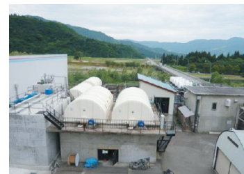
排水処理施設
