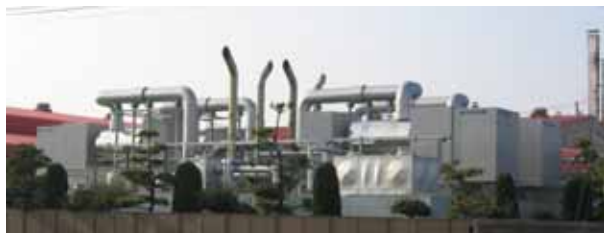
ディーゼル自家発電によるコージェネレーションシステム
